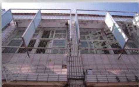
窗戶外架設沖孔遮陽板，阻絕陽光，亦有效達到通風散熱效果。
