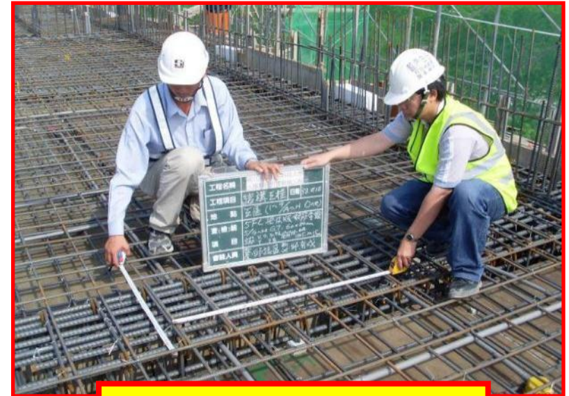
梁板鋼筋自主檢查
