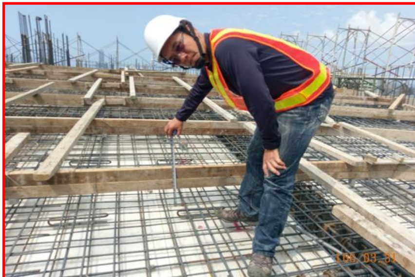
專任工程人員混凝土澆築前督察
